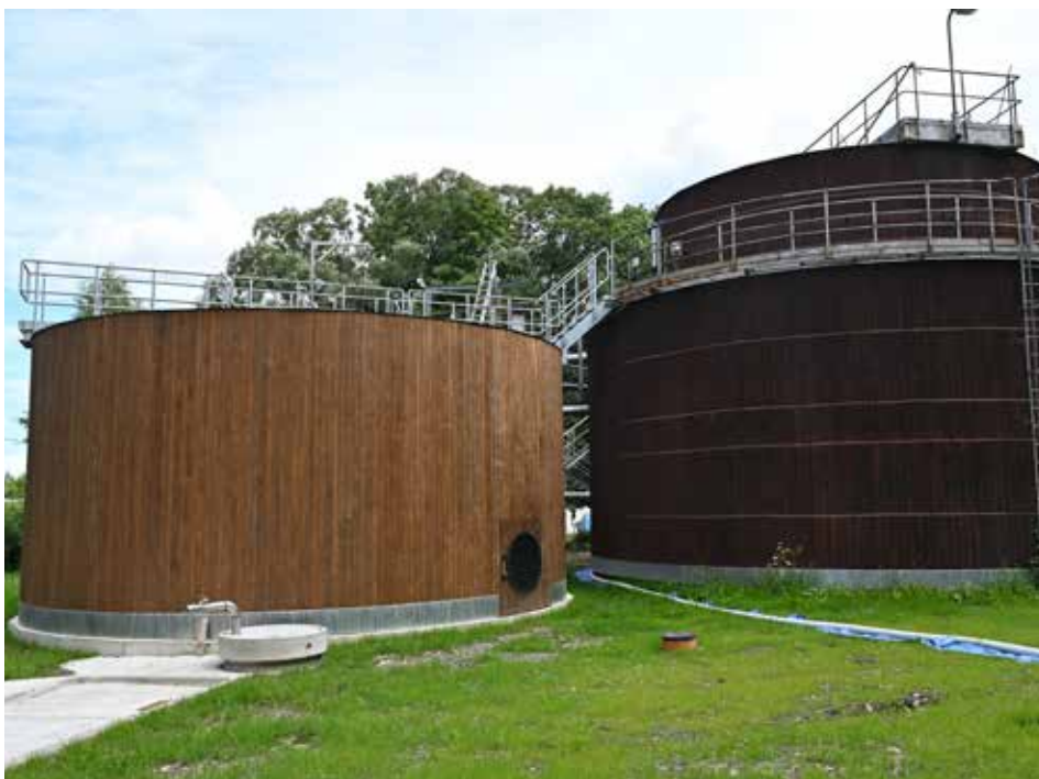
Modernizace a zkapacitnění ČOV přinese užitek celé obci
