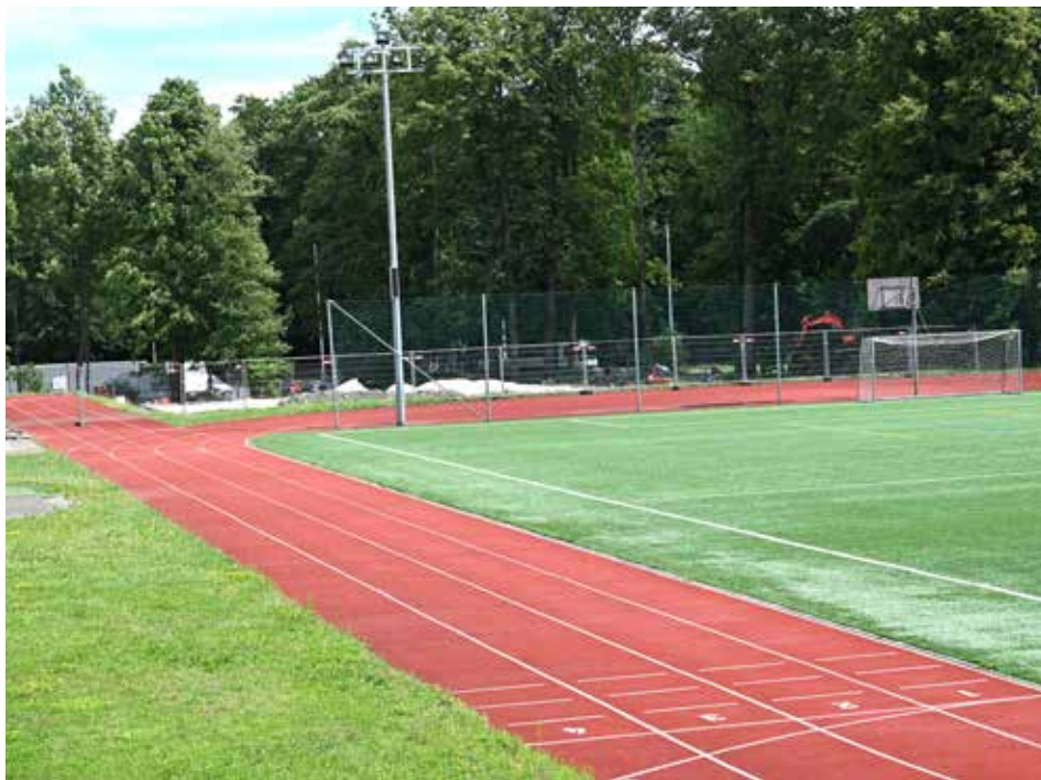
Hala, ve které budou tři beachvolejbalové kurty, se staví hned vedle školního hřiště
